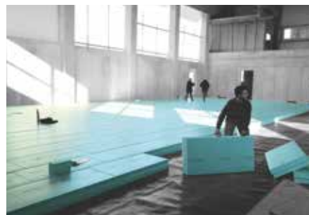
Anwendung der Wärmedämmung FIBRANxps 500-L unter der Gründungsplatte eines Mehrzweckobjektes.
