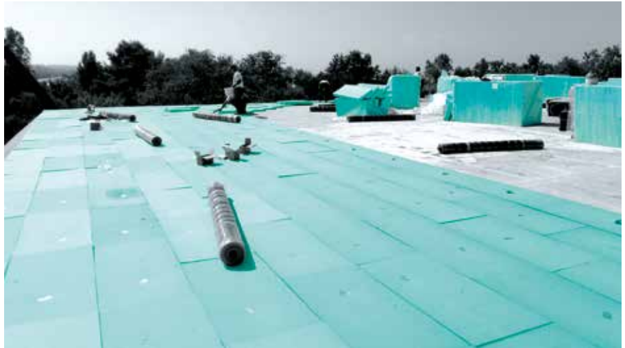
Verbesserung eines Dachgefälles mit FIBRANxps INCLINE und gleichzeitige thermische Sanierung des Flachdaches mit Wärmedämmung.
