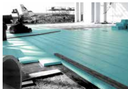
Bodendämmung im Flugzeughangar mit FIBRANxps 700-L.
