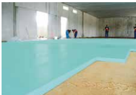
Mit FIBRANxps 300-L wärmegeämmte Grundplatte eines Niedrigenergiehauses.
