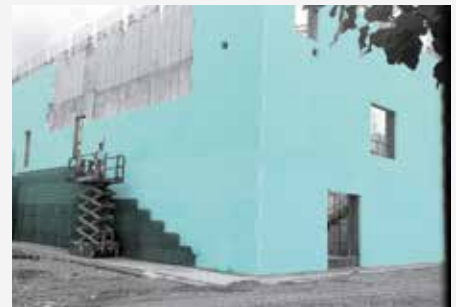
FIBRANxps MAESTRO als Dämmstoff-zwischenlage: Herstellung der Innenfassade aus sichtbarem Naturbeton.
