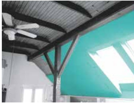
Ausführung der Innendämmung mit FIBRANxps ETICS , die oberflächlich mit einer Dünnschichtfassade und anschließendem Anstrich geschützt wird.
