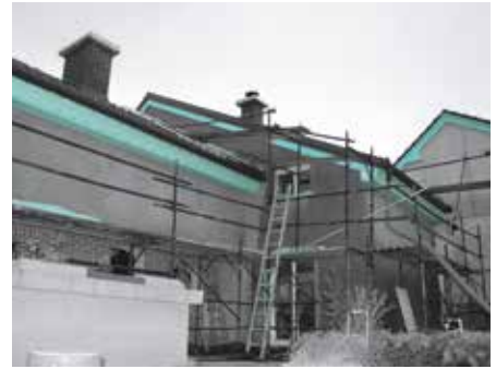
Dachgesims, ausgeführt mit FIBRANxps ETICS , die Dicke hängt von der Spannweite der Konstruktion ab.
