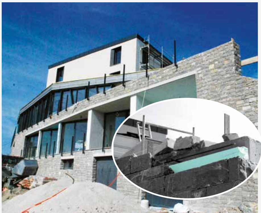
Steinfassade eines Hotels, gedämmt mit tragender FIBRANxps ETICS BT-I Dämmung, auf die mit einem speziellen Prozess Naturstein aufgeklebt wird.
